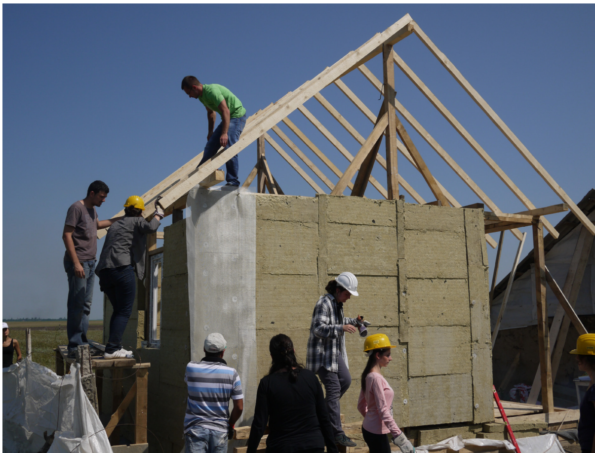
Fig. 1. Studenți UAUIM experimentând adaptarea sistemului Rockshell al Rockwool la structuri din lemn, în cadrul Școlii de vară Arhipera, Belciugatele, iulie 2013 / UAUIM students experimenting the adaptation of the Rockshell system of Rockwool, for wood structures, during the Arhipera summer school in Belciugatele, July 2013
