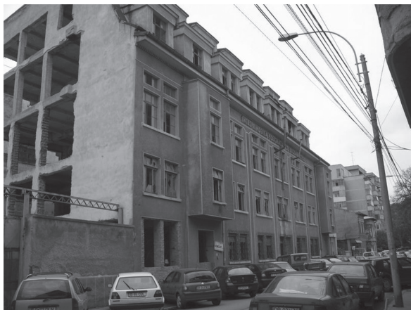
Fig.5 Clădirea din spate a tipografiei, 2006 (autorizație de construire în 1945) / The back of the Printing House in 2006 (authorization to build from 1945) Sursa / Source: Arhiva autorului / Author's archive
