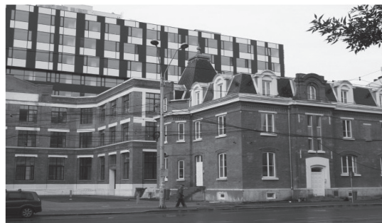
Fig.3 Gardul a fost demolat și vechea curte a tipogra- fieii Cartea Românească a fost deschisă pentru public / The fence is down and the former inner court of the Printing House opened to the public Sursa / Source: Arhiva autorului / Author's archive
