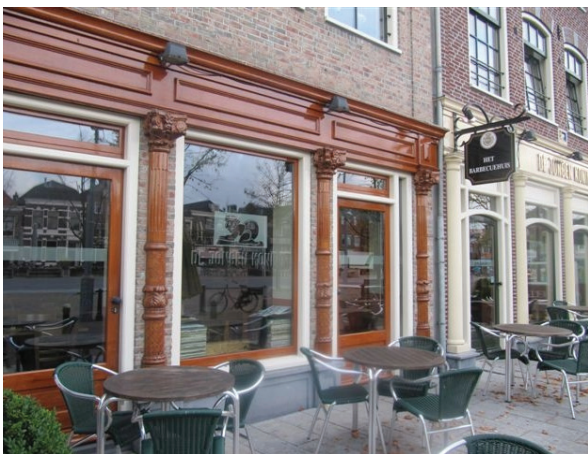
Fig.15. Detaliu de fațadă / Façade detail.. Foto / Photo: Tana Lascu
