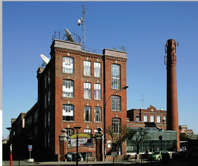
Filatura Le Blan, Lille, Franța / Le Blan Spinning Mill, Lille, France Arhitecți / Architects: Philippe Robert, Bernard Reichen, Biroul de arhitectură ARUP
