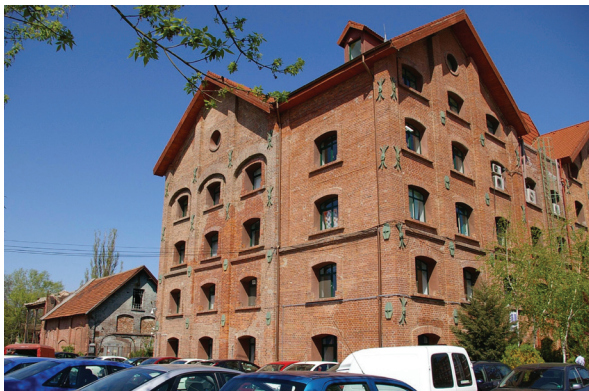
Conversia unei foste clădiri industriale (Fabrica de Glucoză) în imobil de birouri, București / Conversion of an old industrial building (Gloose Factory) into an office building, Bucharest
