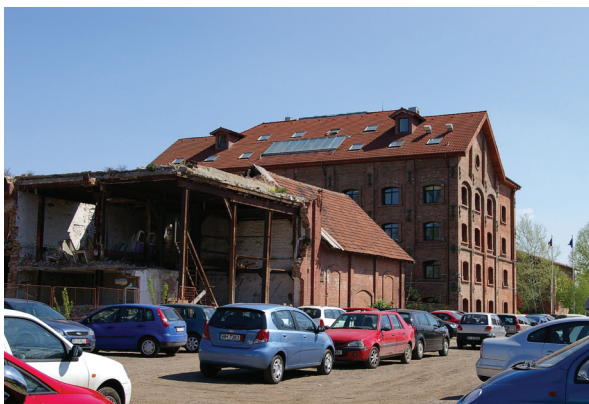
Fig. 3 Demolarea unei clădiri fără valoare arhitecturală care incomoda realizarea proiectului de extindere a imobilului de birouri / Demolition of an old building, with no architectural value, which disturbed the extension of the office building
