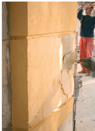
Aplicarea mortarului de var / Application of the lime mortar
