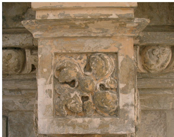
Straturi de finisaj din intervenții anterioare / Finishing layers from anterior interventions
