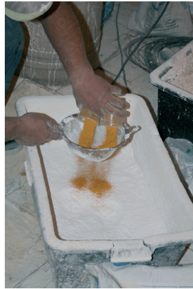
Prepararea mortarului de var cu pigment / Preparation of the lime mortar with pigment
