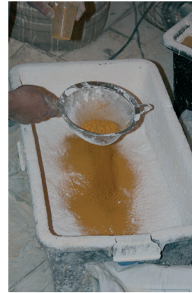
Prepararea mortarului de var cu pigment / Preparation of the lime mortar with pigment
