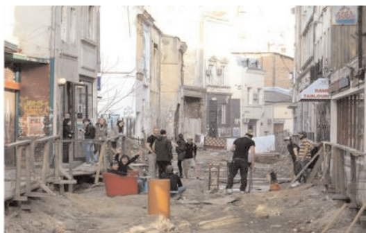
Str. Gabroveni în lucru / Gabroveni Street during works Foto / Photo: © Mihaela Grigorescu
