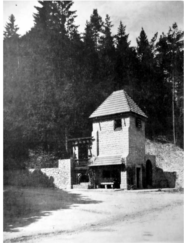
fig.18 Stație de transformare. Arh. Duiliu Marcu
