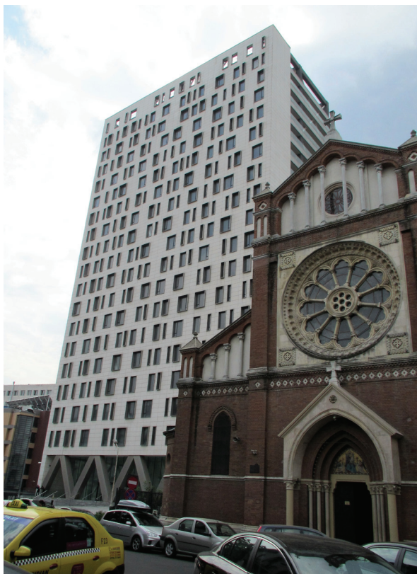
Fig. 3 Clădirea Cathedral Plaza, de lângă Catedrala Sf. Iosif din București, trebuie demolată, conform sentinței definitive a Curții de Apel Ploiești // Cathedral Plaza Building, next to St. Joseph Cathedral in Bucharest, must be demolished, according to the final decision of the Court of Appeal Ploiești. Foto // Photo: R Radu.
