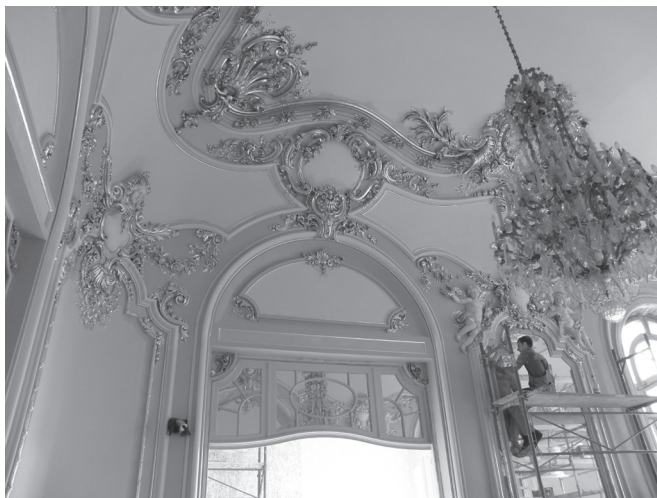
Fig. 8, 9. Starea plafonului după demontarea structurii metalice / The state of the ceiling after removing the metallic structure Sursa / Source: Arhivă personală / Personal archive
