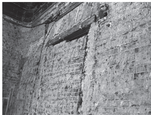
Fig. 10, 11. Lucrări în curs în sălile adiacente / Works in progress in the adjacent rooms. Sursa / Source: Arhivă personală / Personal archive
