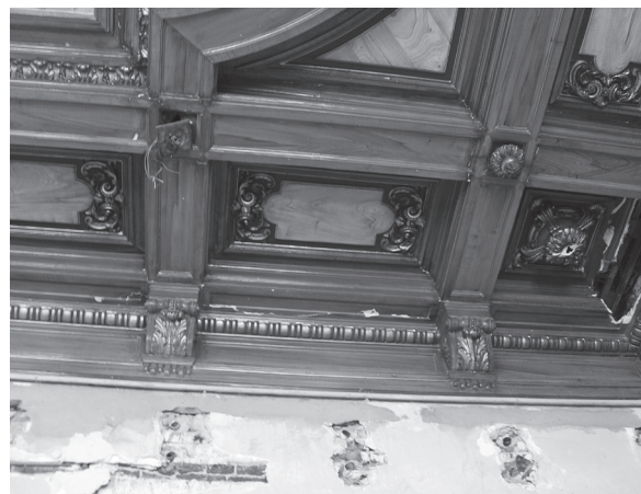
Fig. 8, 9. Starea plafonului după demontarea structurii metalice / The state of the ceiling after removing the metallic structure Sursa / Source: Arhivă personală / Personal archive
