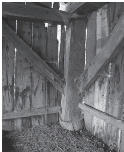
Fig. 5 Șura / The barn. Reparațiile vizau demontarea și înlocuirea porțiunii de la baza stâlpilor / Repairs aimed to the removal and the replacement of the base portion of the pillars
