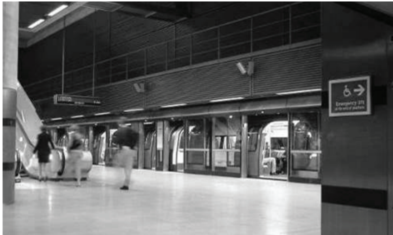
Fig. 18 Închiderea peronului în Stația Canary Wharf de pe linia Jubilee a rețelei de metrou londonez / Platform covering in Canary Wharf station on the London underground Jubilee track Sursa: http://en.wikipedia.org/wiki/Canary_Wharf_tube_station , Foto: Tagishsimon
