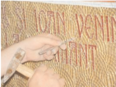
Biserica Sf. Mercurie, București. Finisarea lucrării / St. Mercury Church, Bucharest. Final works
