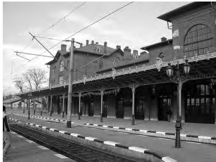
Fig. 3. GARA BURDUJENI după finalizarea lucrărilor de reabilitare – conservare, 2000 – 2006
