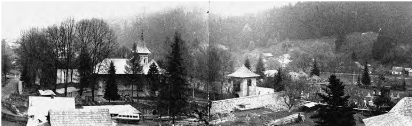
Imagine a incintei din timpul lucrărilor de restaurare
