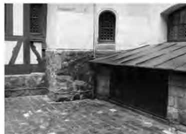
Placare cu tabla a zidariei
