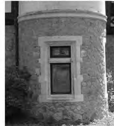
Tencuiala degradata , umezeala Umezeala ascensionala, vegetatie parazitara
