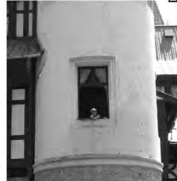
Tencuiala degradata , umezeala Umezeala ascensionala, vegetatie parazitara
