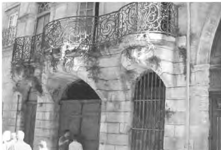
Fig. 5 Locuință tipică din Bruxelles , construită în sec. al XVIII-lea și abandonată de proprietar de 15 ani. În 2003 au fost realizate în regim de urgență operațiuni de restaurare
