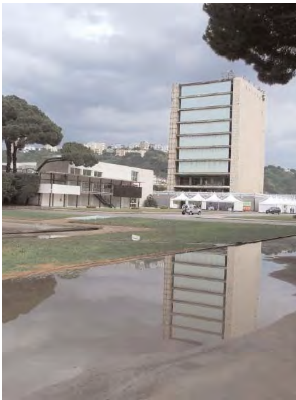
a. Mostra d'Oltremare, Napoli (1938), arhitect: Venturino Venturi. Foto: M. Boștenaru, 2006
