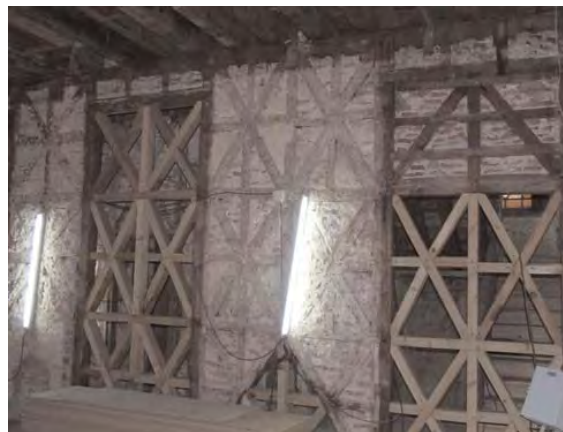
Fig. 2. Clădiri „gaiola pombalina”, Lisabona, Portugalia, tip datând de după cutremurul din 1755.
