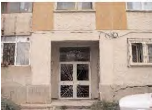
Tâmplării degradate
