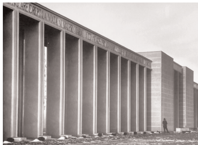
Pavilion expozițional, 1938. Arhitect Horia Creangă
