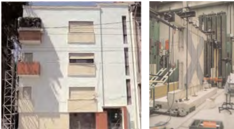
Fig. 5. Experimente de consolidare în sistem FRP a unor clădiri interbelice bucureștene realizate la Institut für Massivbau, Universität Karlsruhe (TH)
