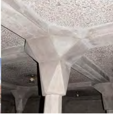
Fig. 22. Prima biserică din beton armat. Arhitect Jože Plečnik
