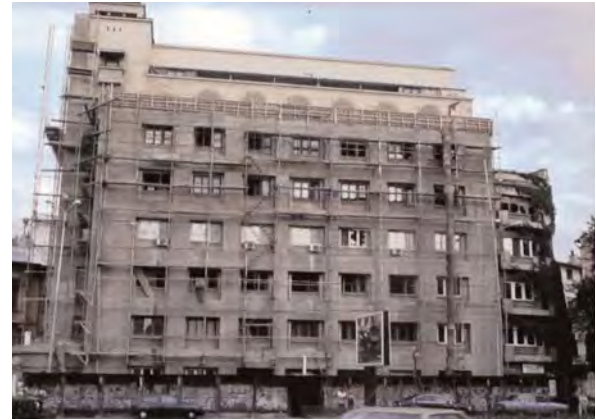
Fig. 3. Blocul Wilson în consolidare
