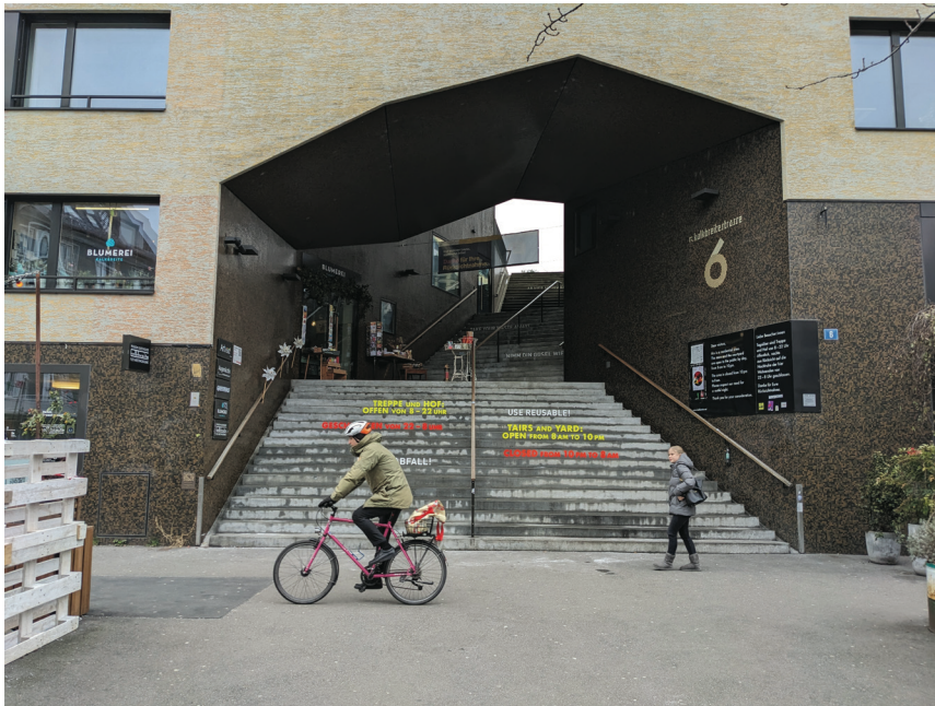
Fig. 3. Acces către curtea interioară./ Access to the inner courtyard Sursa/ Source: Autorul/ The author
