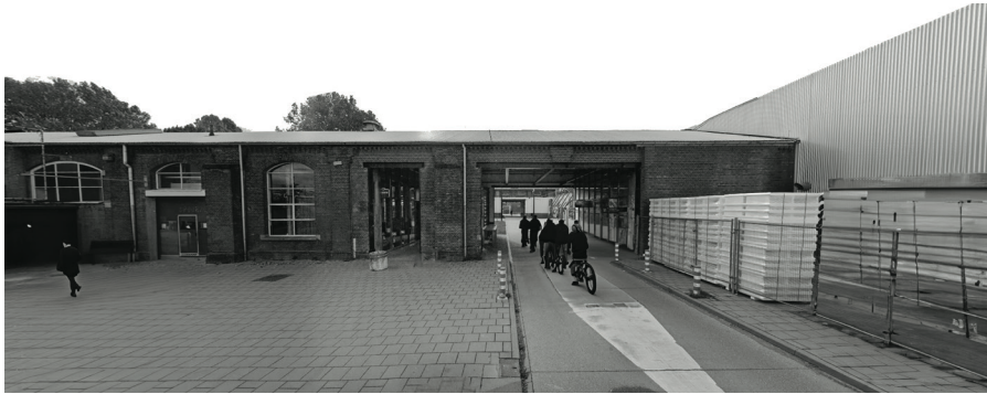
Fig.9. Piața Spoorzone, perspectivă înspre pasajul pietonal, legătură pe sub calea ferată între cartiere ale orașului și zona industrială./ De Spoorzone square, view towards the pedestrian underpass, connecting neighborhoods of the city and the industrial area beneath the railway. Sursa/ Source: Autorul/ The author
