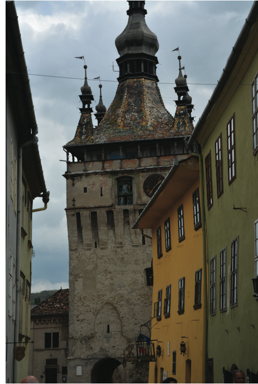
Fig. 2. Front de clădiri colorate Piaţa Muzeului - Sighişoara/ Front of colorful buildings Museum Square - Sighişoara. Sursa/ Source: Arhivă personală/Personal archive.
