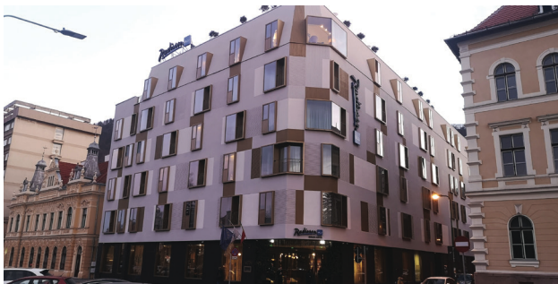
Fig. 5. Reconversie clădire Palatul Telefoanelor – Brașov / Hotel Raddison Blu Aurum – Brașov, Arhitectură: Arhi Grup/ Conversion of the Telephone Palace building – Brașov / Hotel Raddison Blu Aurum – Brasov, Architecture: Arhi Grup. Sursa/ Source: Arhivă personală/Personal archive.
