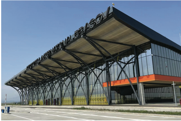
Fig. 7. Compoziție bicoloră galben-portocaliu Aeroportul Internațional Brașov – Ghimbav. Arhitect: Dorin Ștefan/ Bicolor yellow-orange composition of Brașov – Ghimbav International Airport. Architect: Dorin Ștefan. Sursa/ Source: Arhivă personală/Personal archive.
