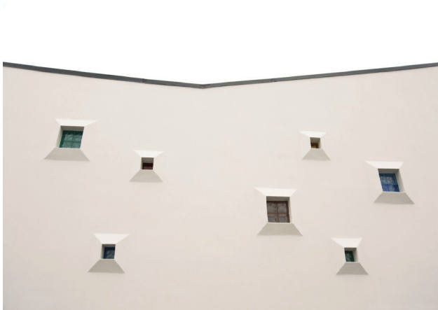
Fig. 7. Fațada perforată cu goluri colorate./ Perforated facade with coloured lights. (c) Fotografie: Ovidiu Micsa , Arhitectură: Andreescu&Gaivoronschi Architects / (c) Photo: Ovidiu Micsa , Architecture: Andreescu & Gaivoronschi Architects
