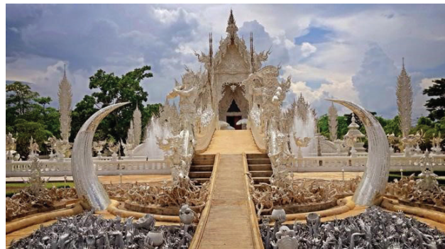
Fig. 2. Podul reprezintã samsara sau ciclul renașterii. Betonul colorat ca pãmãntul face tranziția, dupã trecerea podului, cãtre templul alb dominant./ The Bridge represents the samsara or the cycle of rebirth. The soil-colored concrete transitions towards the dominantly white temple after crossing the bridge. (c) GusbellSStudio & Phongsak Manodee.
