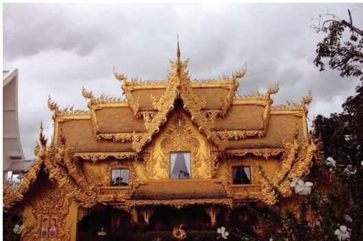
Fig. 1. Clãdirea de aur este lumea materialã ce abundã de bogãtie. De asemenea, interesant este faptul cã ea reprezintã și toaleta clãdirii din templul complexului. (c) Adrian Fleur./ The Golden Building represents the material world, abundant in wealth. Interestingly, it is also the restroom building of the temple complex. (c) Adrian Fleur.
