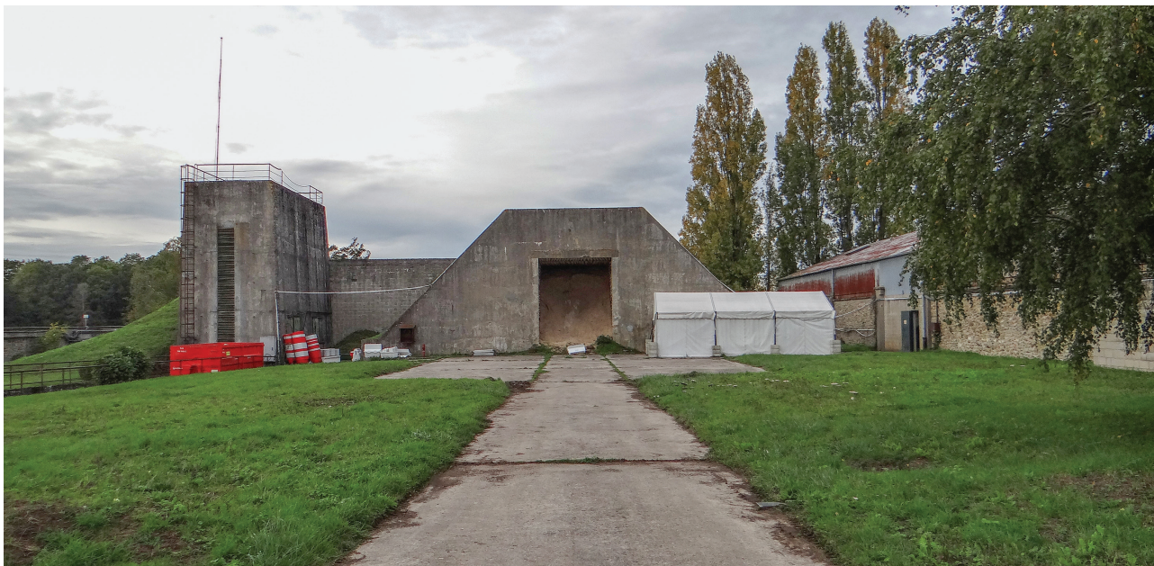
Fig. 3. „Hall A”, curtea interioară. Aceste structuri din beton armat erau folosite pentru amplasarea Țintelor pentru artilerie. Sursa: autorul./ The inner courtyard of Hall A. These concrete structures were formerly used for placing targets within the artillery firing range. Source: the author.
