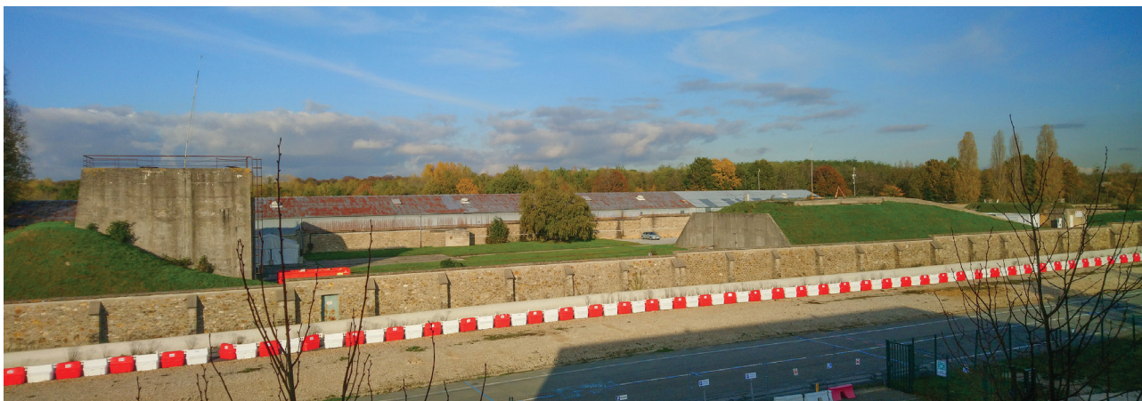
Fig. 2. Incinta „Hall A” văzută dinspre un centru de cercetare învecinat. Impresia de fortăreață este dată de zidul de piatră lung de 640m care împrejmuieste poligonul de tir. Sursă: autorul./ Hall A compound as seen from a neighboring research facility. The fortress-like impression is given by the 640m long stone wall surrounding the shooting range. Source: the author.
