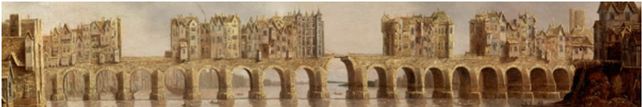
Fig. 7. Pictură de Claude de Jongh din 1632 a vechiului London Bridge, construit între 1176 și 1209 și care a supraviețuit până în 1831, fiind cel mai longeviv pod locuit. Construcțiile erau amplasate de la început de-a lungul lui, aceasta fiind o manieră uzuală de a acoperi o parte din cheltuielile de mentenanță./Painting by Claude de Jongh from 1632 of Old London Bridge, built between 1176 and 1209, which survived until 1831, being the longest-lasting inhabited bridge. A usual way to cover a part of the maintenance expenses of the bridge was building constructions upon it.
