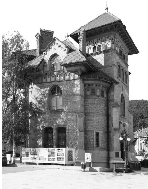
Fig. 9. Fosta Bancă Petravoda, actualul Muzeu Cucuteni, Piatra Neamț – alternanța profilului acoperișului amintește de spațiul ondulat/ Former Petravoda Bank, the current Cucuteni Museum, Piatra Neamț – the alternation of the roof profile reminds of the wavy space
