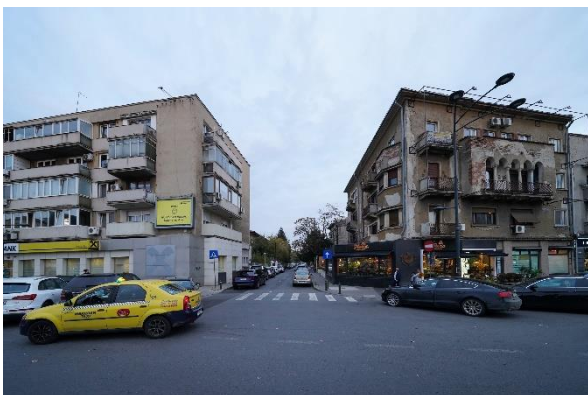
Fig. 2. Strada Bitoliei văzută de pe Calea Dorobanților, situația actuală. Sursa: autorul./ Bitoliei street seen from the Calea Dorobanților, present situation. Source: the author.
